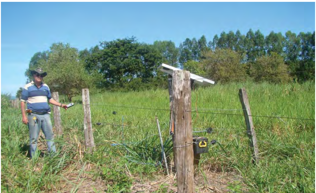
Figura 9. Instalaciones de la cerca eléctrica en el potrero de maternidad con la celda solar, regulador y batería. El dueño de la Fazenda San Francisco (Sr. Roberto F. Coelho) está chequeando el voltaje correcto de la cerca. Al fondo el corredor de árboles de eucalipto, utilizado por los pumas como corredor (ver texto). Foto: Rafael Hoogesteijn.
